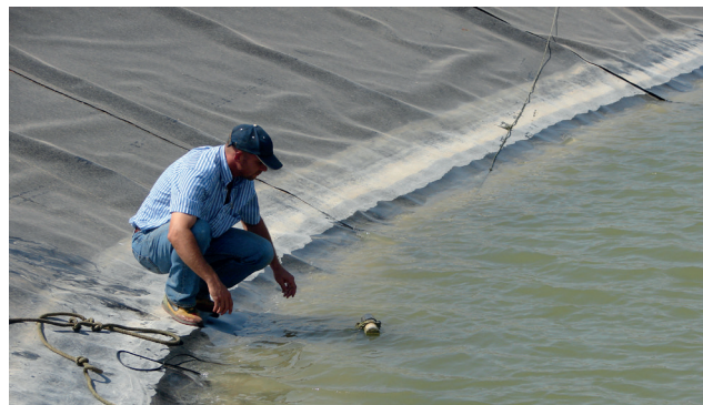
DUMO Algacleaner instalado en balsa de riego
